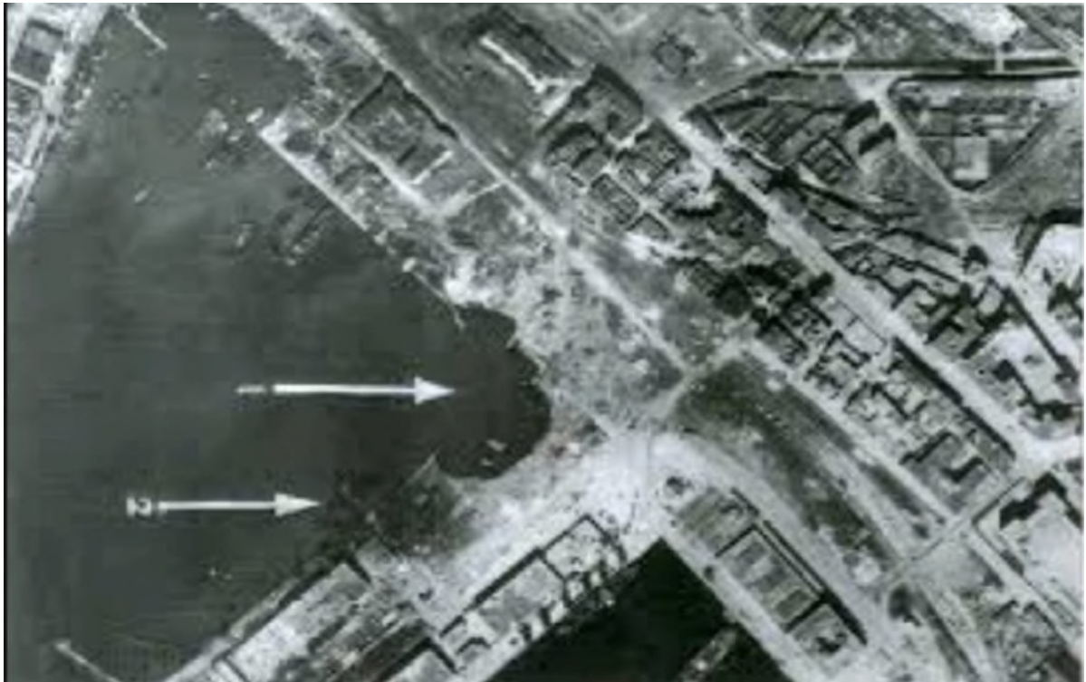
Figura 4 a Veduta aerea dei danni causati dall'esplosione della Caterina Costa
